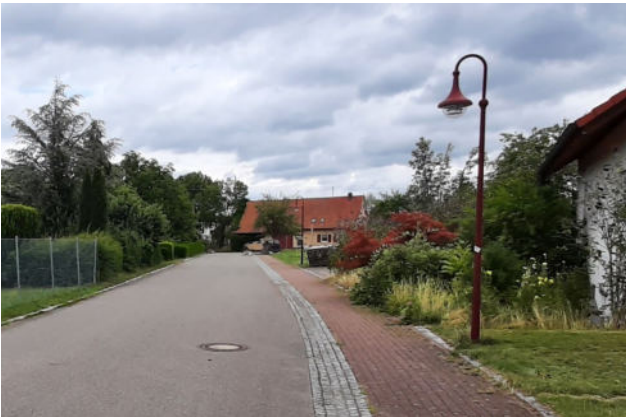
Abb. 25: Entlang des Gehwegs auf der südlichen Seite des Fichtenwegs befinden sich durchgehend Straßenlaternen (Blick in nordöstliche Richtung).
